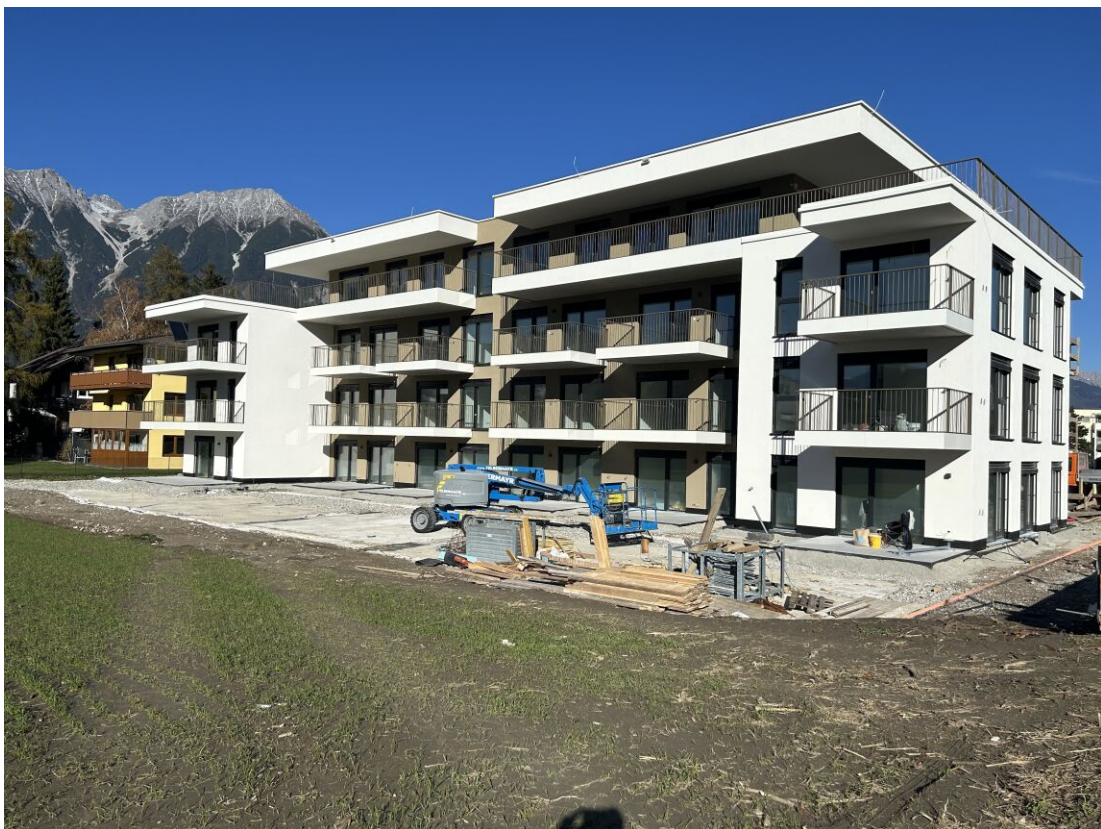
Foto Außenansicht Vorderseite
